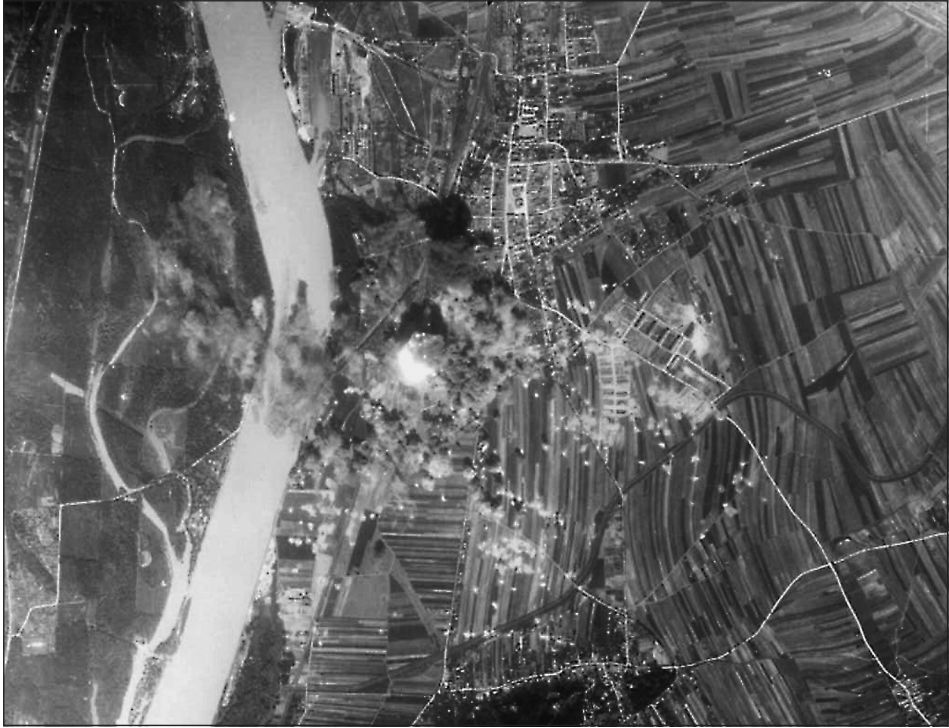
Abb. 16: Bombardierung des Raffineriegeländes am 8. Juli 1944 ( http://www.461st.org/Missions/June1944.htm , zur Verfügung gestellt von H. GLANTZBERG). – Fig. 16: Bombing of the refinery area on July 8th, 1944 ( http://www.461st.org/Missions/June1944.htm , Courtesy of H. GLANTZBERG).
