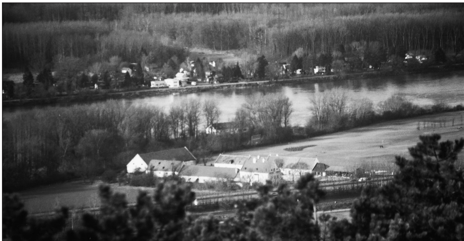
Abb. 1: Der Tuttenhof, nahe der Donau, mit U-förmiger Anordnung von Wohntrakt und Wirtschaftsgebäuden, im Besitz des Stiftes Klosterneuburg, 1400 namentlich erwähnt, im 17. Jh. durch einen Getreidekasten erweitert und zur heutigen Form ausgestaltet (Foto: H. RAZ, 2006). – Fig. 1: The Tuttenhof, near the Danube, with a U-shaped configuration of the housing unit and farming buildings. It is owned by the monastery Klosterneuburg and was mentioned by name in 1400. In the 17 th century it was enlarged by a granary to today's form (Photo: H. RAZ, 2006).
