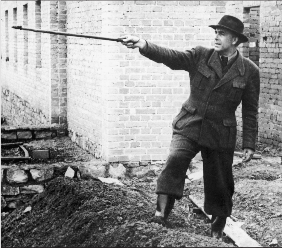
Abb. 10: Hans STUBBE vor den in Bau befindlichen Institutsgebäuden in Gatersleben nach dem Zweiten Weltkrieg (zur Verfügung gestellt v. IPK, R. SCHNEE). – Fig. 10: Hans STUBBE in front of institute buildings under construction in Gatersleben after the second World War (Courtesy of IPK, R. SCHNEE).
