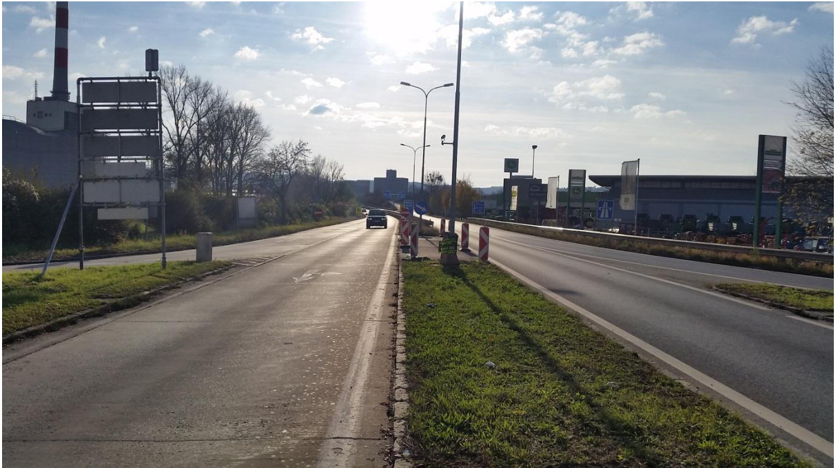
Foto 5: Kreuzung B3 – AST Korneuburg Ost – Kaiserallee, Blickrichtung Abfahrt A22
